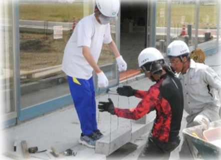
建設現場にて。駐車場の縁石の位置を探っています。
